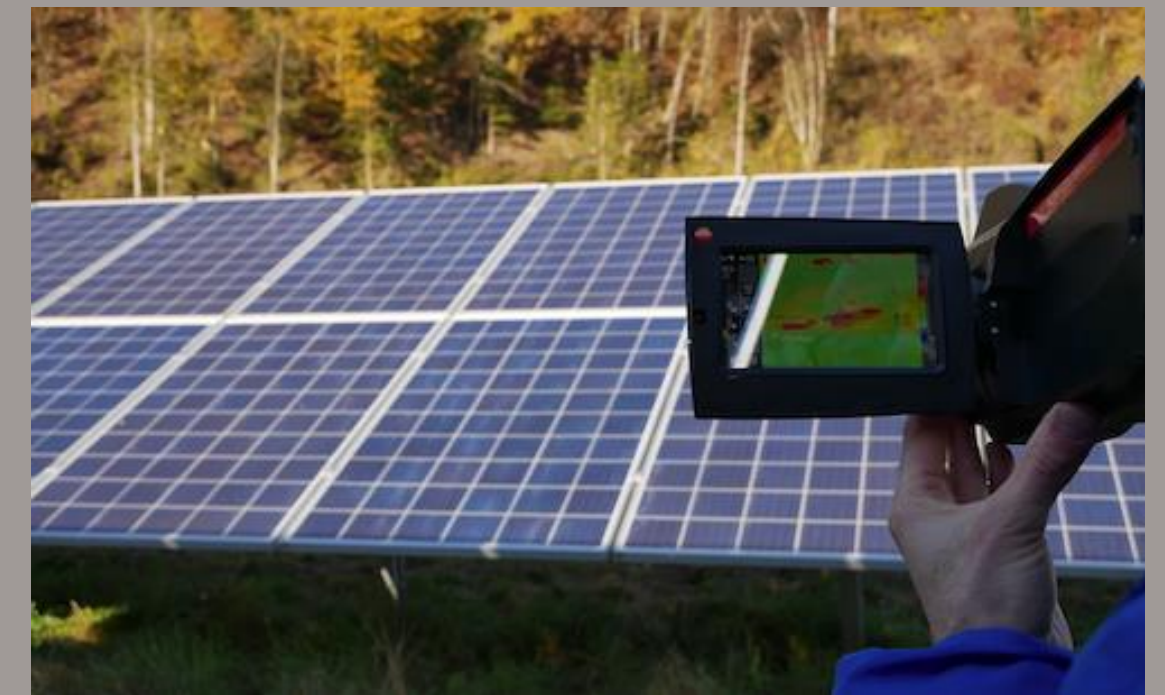
Optimierter Betrieb von PV-Anlagen durch Digitalisierung, Kärnten
